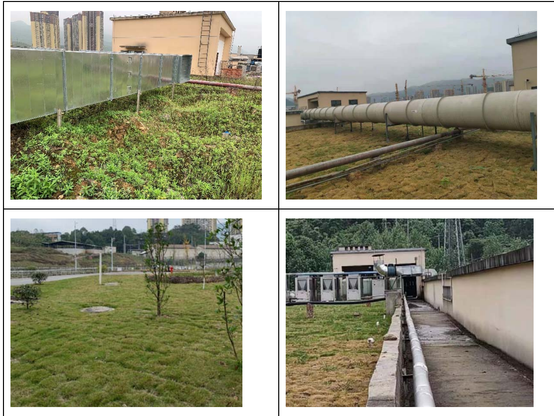
图 4.1-11 项目绿化布置现场图片
